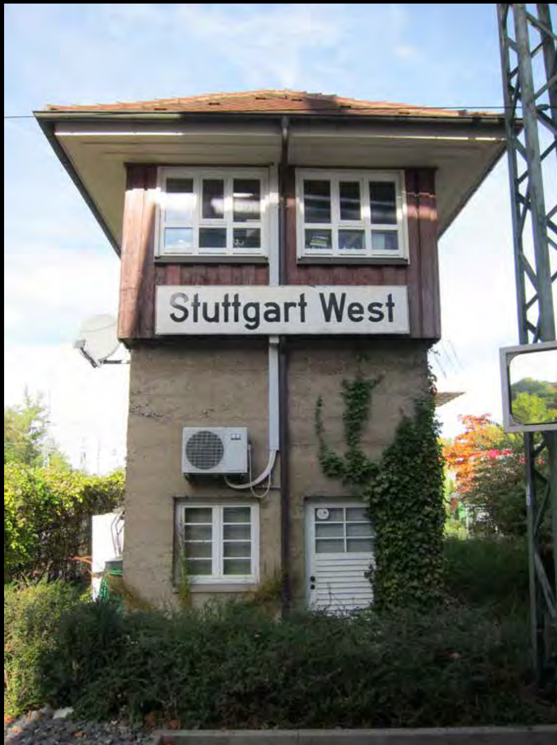
Gerrit Terstiege, Kurt Weidemanns Atelier im Stuttgarter Stellwerk am Westbahnhof, einem der ersten Gebäude Deutschlands aus Sichtbeton von 1927
